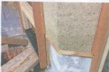
Als je kalkhennep in situ verwerkt, kun je kierdicht bouwen.
